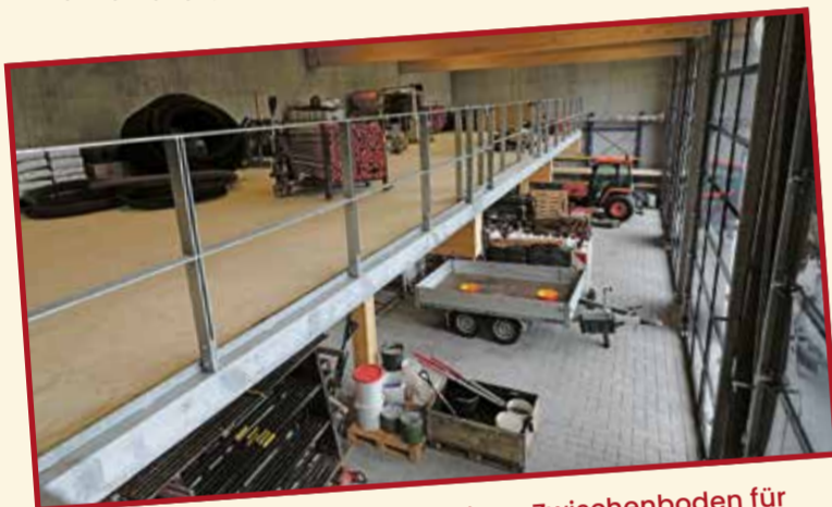
Die Kalllagerhalle verfügt über einen Zwischenboden für zusätzliche Lagerfläche. Fotos: Olaf Winkler
