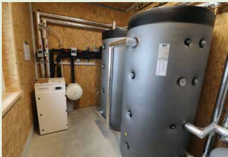
Die Wärmepumpe des Bauhofes bezieht ihre Energie aus dem Klärbecken der Kläranlage.
